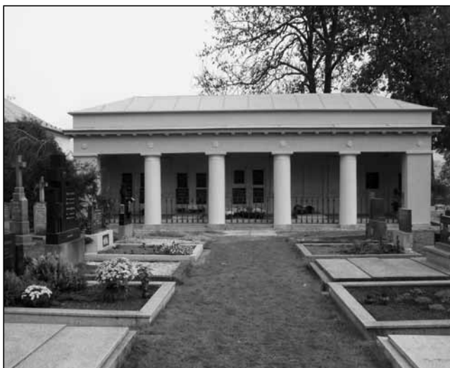
Hrobka po rekonstrukci.
