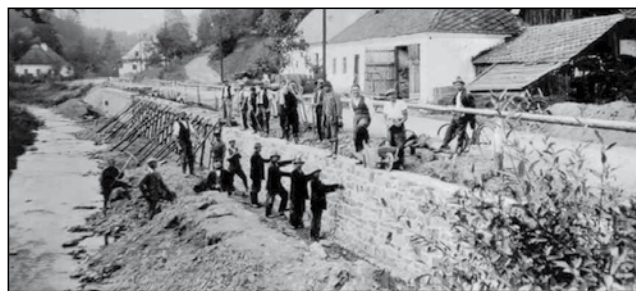
Pohlednice z roku 1930, kdy Keprtovičtí stavěli u Libavského potoka opěrnou zeď. Tato zeď se zachovala až do současnosti. Archiv Jindřicha Machaly.
