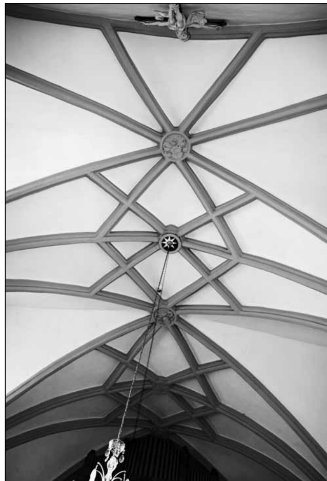
Obr. 2 Pohled do klenby v lodi s nově natřenými žebry a pěti svorníky.
