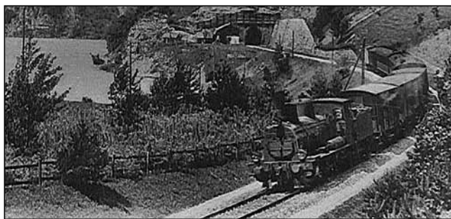
Traťový úsek Gotthardské železnice – severní výjezd Göschenen.
